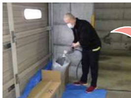
△車庫シャッター内側に水嚢(すいのう)を設置
